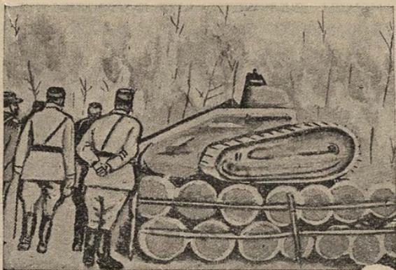
Рис. 68. Приспособление для переправы танков через неглубокие реки.
