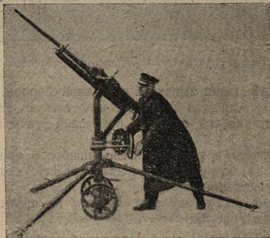
Рис. 57. Итальянский 12-мм пулемет Сафат на противотанково-зенитной установке.
