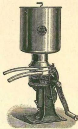
Рис. 109. Сепараторъ модели 1911 г., Альфа-Лаваль Колибри.
