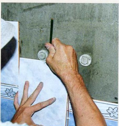
Вам нужно найти то место, где будет находиться разрез, на самой плитке, которую вы должны уложить на стену в месте разъема. Для этого возьмите плитку, на которой отметили его ширину, сделайте отрезок той же ширины на новой плитке, учитывая длину, что уже измерили.
