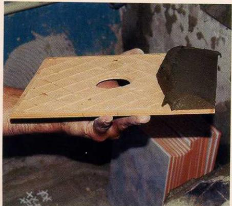
▲ Теперь, когда вы точно знаете, что все сойдется, можно приступить непосредственно к укладыванию плитки на стену. Приготовьте цементно-песочный раствор и с помощью полуутерка нанесите необходимое количество на внутреннюю поверхность плитки. Сколько именно нужно раствора, определите на глаз.
