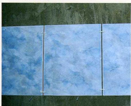
▲ Распорки вбиваются в отштукатуренные стены с помощью молотка, так как имеют с одной стороны заостренный наконечник. В зависимости от того, что именно вы делаете, меняйте расположение распорок. Если у вас на очереди угол, крепите крестовины между плитками, ориентируясь на толщину слоя застывшего здесь раствора.
