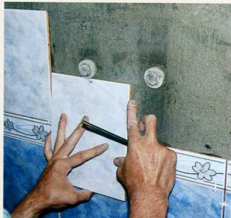
▲ При облицовке стены около разъемов для кранов с горячей и холодной водой придетсярезать плитку. Сначала следует измерить длину и ширину будущего выреза, получить прямоугольник, с помощью которого потом можно будет определить диаметр выреза.
