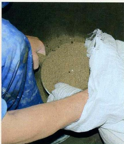
▲ Прежде чем приступить к процессу облицовки стен плиткой, нужно подготовить ее поверхность: сначала удалить остатки обоев, затем отштукатурить и таким образом сделать гладкой. Позаботьтесь о наличии материалов: нужен кварцевый (речной) и обычный песок, цемент, металлический таз-сито. Нужное количество речного песка насыпьте в таз.
