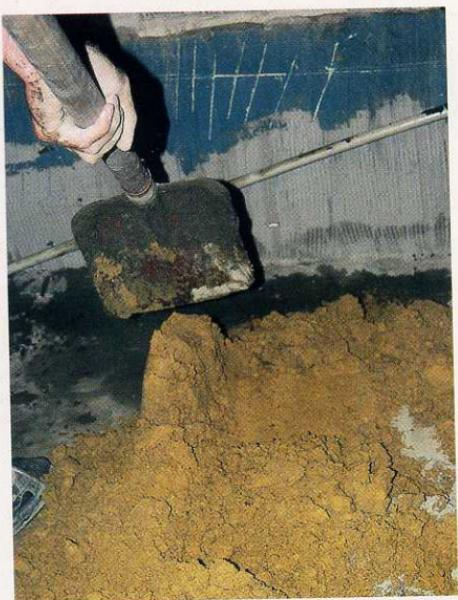
▲ Для замеса «тощего» раствора, подходящего для проведения облицовки вертикальной поверхности, возьмите цемент марки 400. Если же вы приготовили цемент марки 500–600, исходите из пропорций 1:8. Прочность таких растворов невысокая, но потом они не дают трещин.
