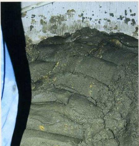
Возьмите зубчатый шпатель или полуутерок — с его помощью вы будете наносить приготовленный раствор. Учтите, что растворы действуют только в течение 3—4 ч, а потом уже не пригодны для использования. Сначала нанесите достаточно толстый слой на нижнюю часть поверхности стены, дальше последовательно кладите ряды по направлению вверх.
