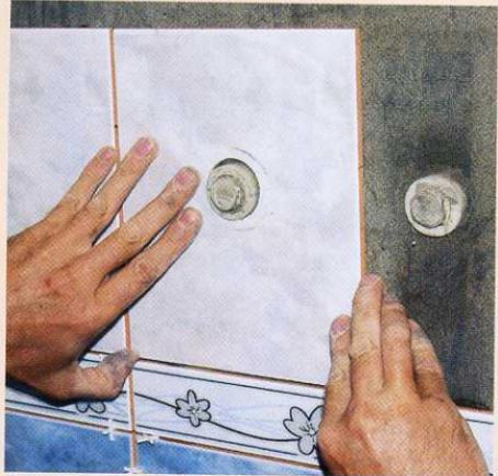
Равномерно распределите раствор по всей поверхности. По поводу качества плитки: выбирайте такую плитку, которая не меняет цвет и рисунок под воздействием попадающих на нее солнечных лучей. Также плитка должна иметь определенную теплопроводность — она не должна растрескиваться от резкого перепада температуры.
