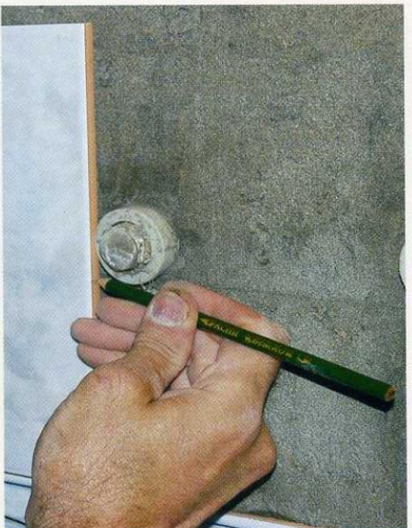
▲ Теперь вам необходимо определить, какую длину будет иметь вырез. Следует сделать две отметки карандашом: нужно провести в своем воображении ровную линию от разъема под кран до крайней плитки и поставить точки-отметки. Соединив визуально эти точки, измерить получившийся отрезок линейкой.
