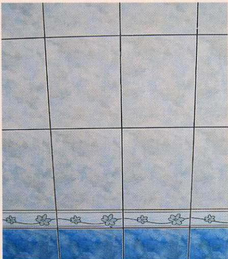
Для того чтобы выложить бордюр, следует использовать плитку соответствующего размера. Распорки при облицовке вбивайте только с нижней и боковых сторон.
