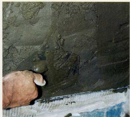
▲ Дождитесь, пока цементно-песочная смесь, т. е. ее первый слой, высохнет, и можете наносить еще один поверх него. Этот пласт не стоит делать таким же толстым и объемным, как предыдущий. Цель его нанесения — сделать поверхность стены идеально ровной. Вы должны окончательно выровнять стену с помощью той же кельмы (или правила).
