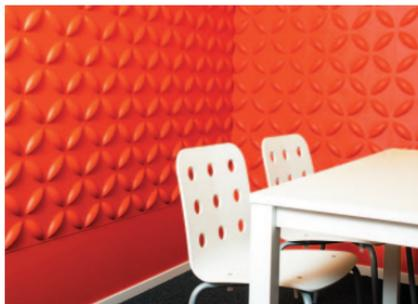
Установку производят с помощью небольших деревянных брусков, которые укладывают перпендикулярно относительно расположения самих панелей. К стене обрешетку крепят шурупами с шагом не более 450 — 500 мм, а сами панели прикручивают саморезами.
