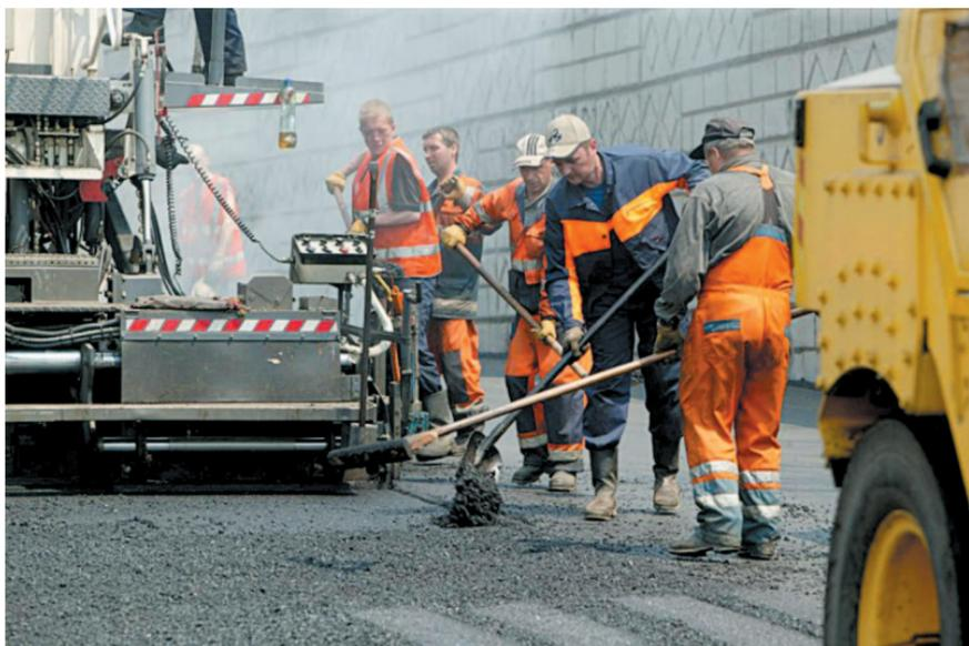
Современный дорожно-строительный конвейер позволяет укладывать сотни метров асфальтобетонного покрытия за рабочую смену.
