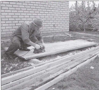
Изготовление щита «палубного паркета» пола
