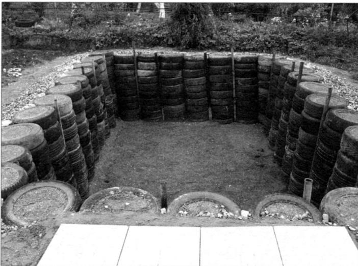
Нулевой цикл работ по строительству бассейна закончен. Вскоре все эти конструкции будут закрыты полотном из винилового плёнки, а окружающая территория — покрыта тротуарной плиткой
