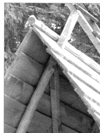
Соединение коньковых досок и коньковой слеги
