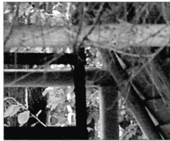
Крепление основных стоек со стропильными ногами внакладку (вид изнутри)
