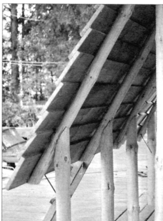
Соединение боковых стоек со стропильными ногами косым прирубом
