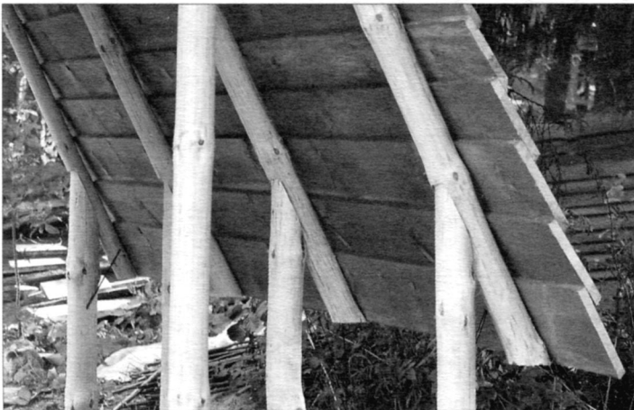
Верхние доски крыши прикрывают нижележащие
