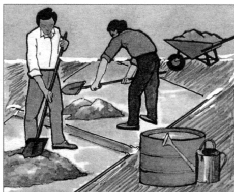
Рис. 10. Подготовка бетонного раствора на щитах
