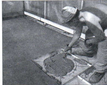
Покрывание пола песчаным бетоном (цементный раствор)
