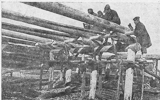
В Собинском районе Татреспублики строится большой мост через реку Собинку. Мост свяжет колхозы с районным центром в с. Раздолье. На снимке: колхозники колхоза «Кзылкураш» работают на стройке моста через Собинку
