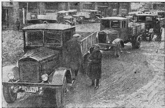
Автомашины 2-й автобазы Метростроя выезжают на работу к шахтам
