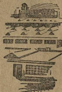
Создан первый в СССР Алюминиевый комбинат, состоящий из завода полупроизводительностью в 12 000 тонн в год, собственно алюминиевого завода, производящего из этого полупроизводительности в 6 тысяч тонн алюминия в год, и электролитической, которая будет перерабатывать сырой алюминий в болванки и т. д. для заводов обрабатывающей промышленности. Алюминиевый комбинат будет работать на тихвинских бокситах и на электрозергии Волховстроя.
