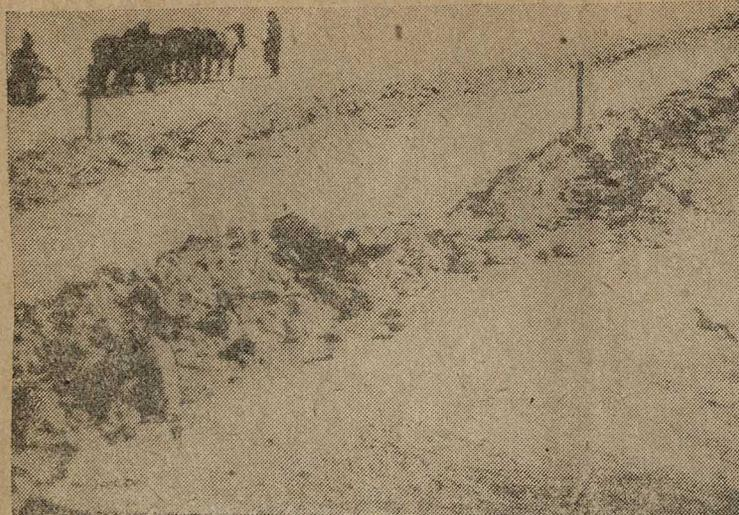
Рис. 4. Пахание снега треугольником с конной тягой.
