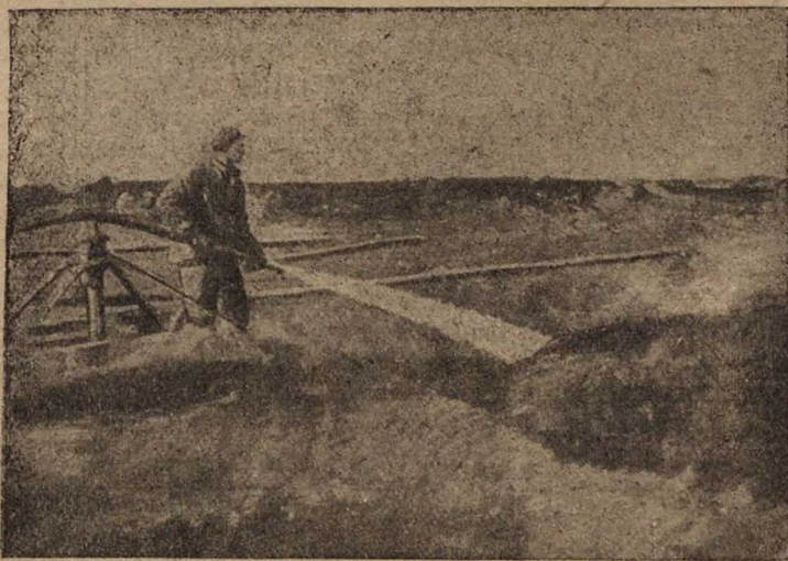
Размыв залежи торфа струей воды.
