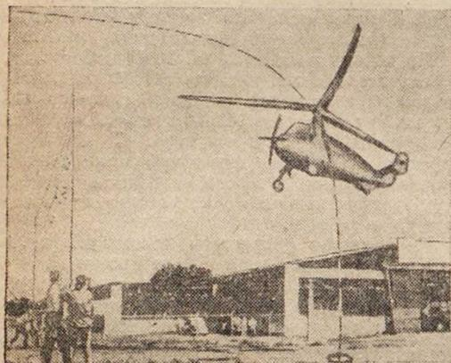
осуществляется посредством изменения угла наклона оси ротора. На земле у автожира „Питкертн“ лопасти складываются назад, и мотор переключается на заднее колесо так, что автожир превращается в автомобиль. Мотор мощностью в 175 лошадиных сил обеспечивает аппарату скорость полета в 250 км/час.
