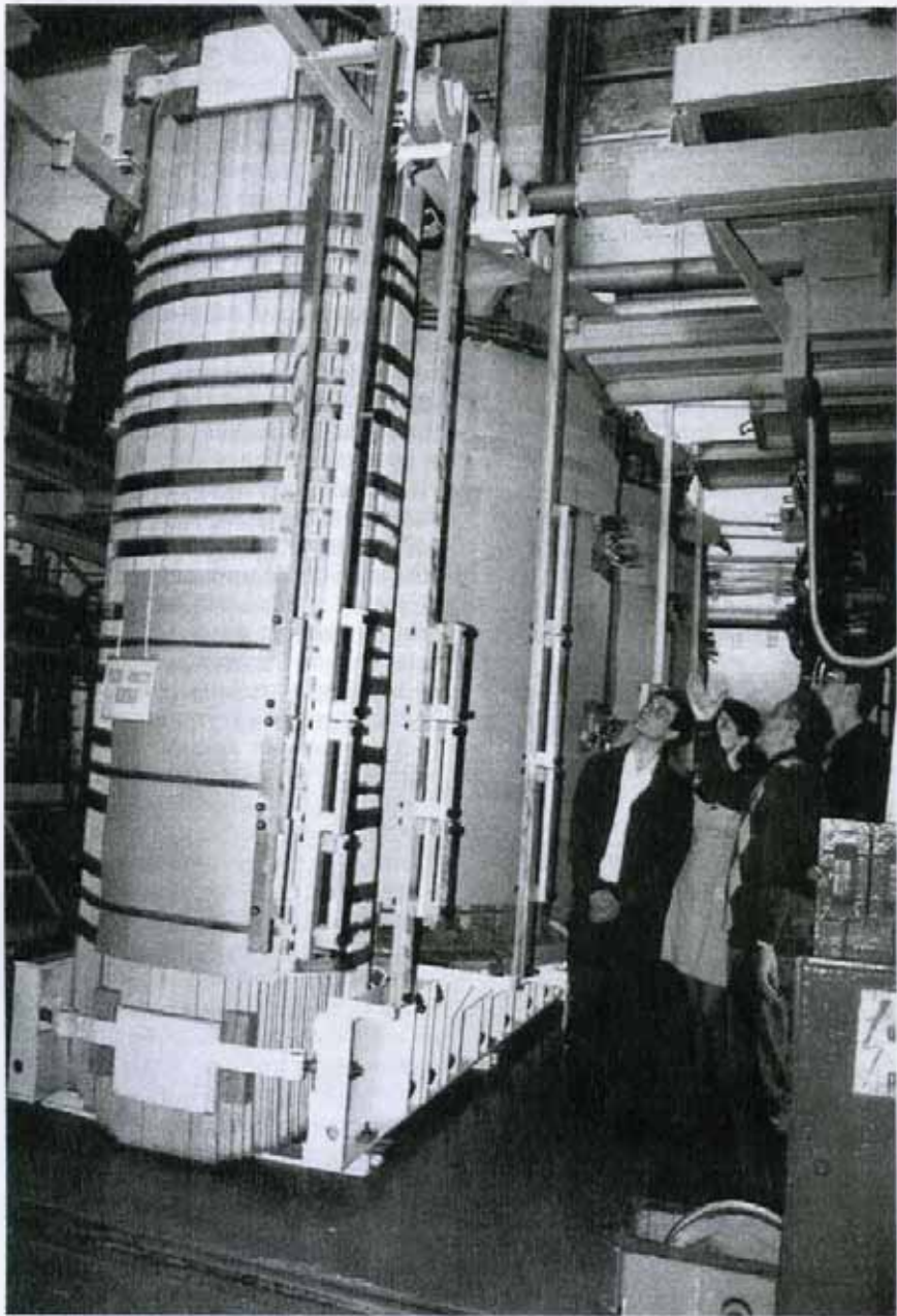
Студенти-електромеханіки знайомляться з обладнанням трансформаторного цеху (1986 р.)
